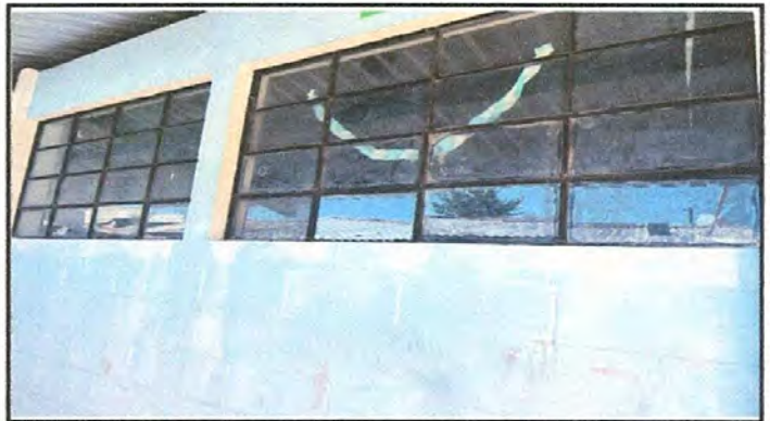
Foto 4: Sustitución de Vidrios
