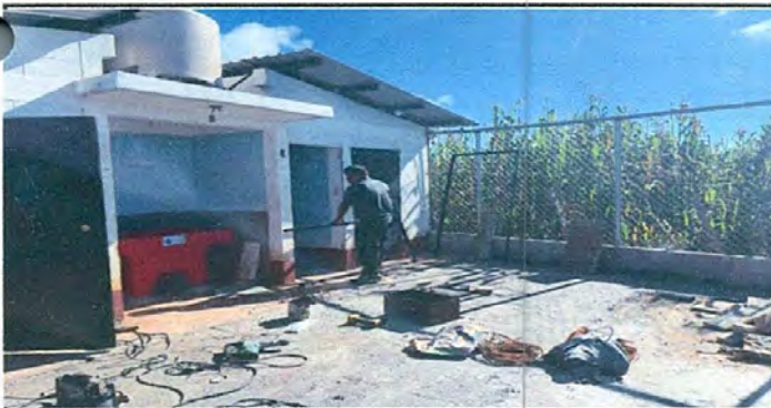
Foto 5: Sustitución de puerta en servicios sanitarios
